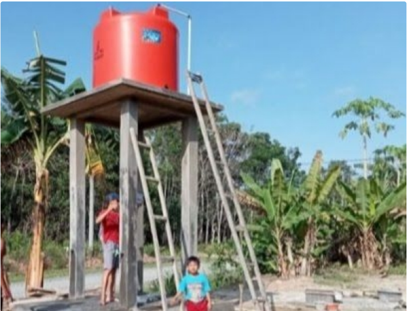
Pembangunan sumur bor di Desa Fajar Baru
