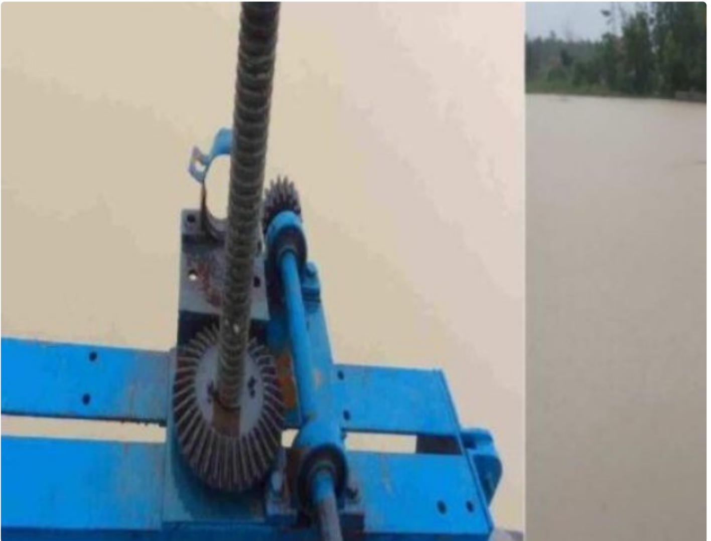
Pintu air Albaret Simpang Mesuji
